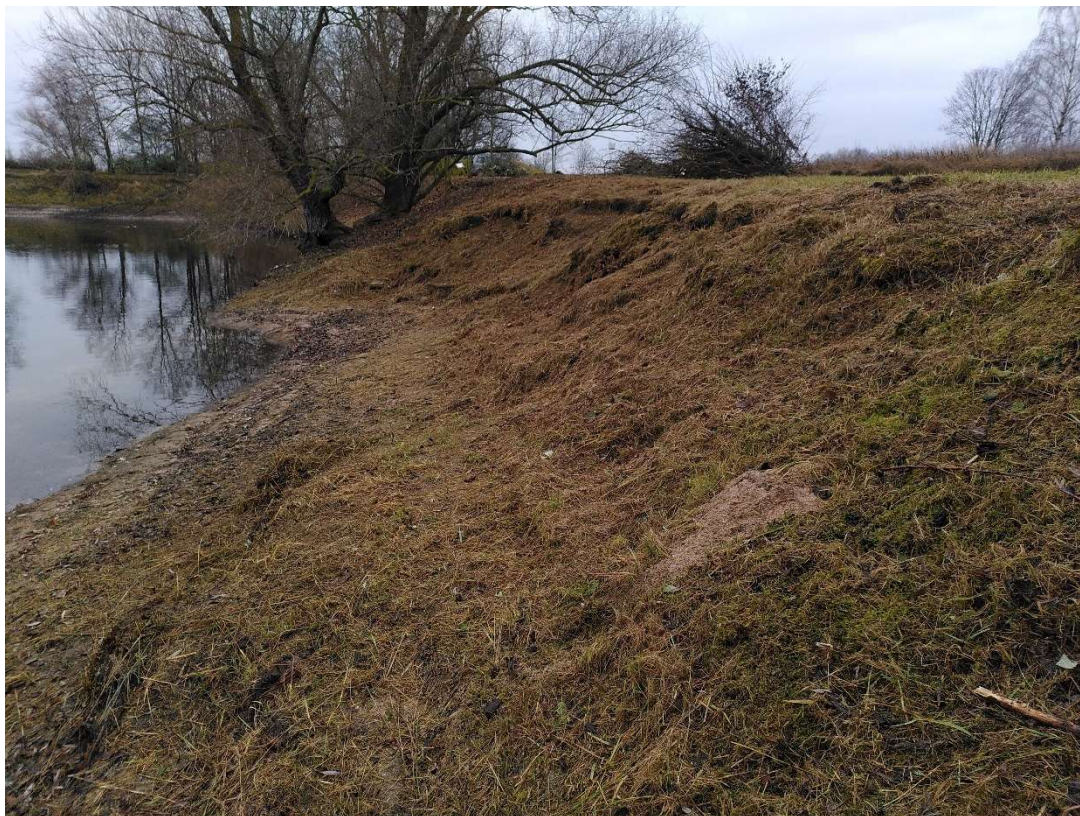
Abb.56 – Kahlschlag an der Uferböschung
