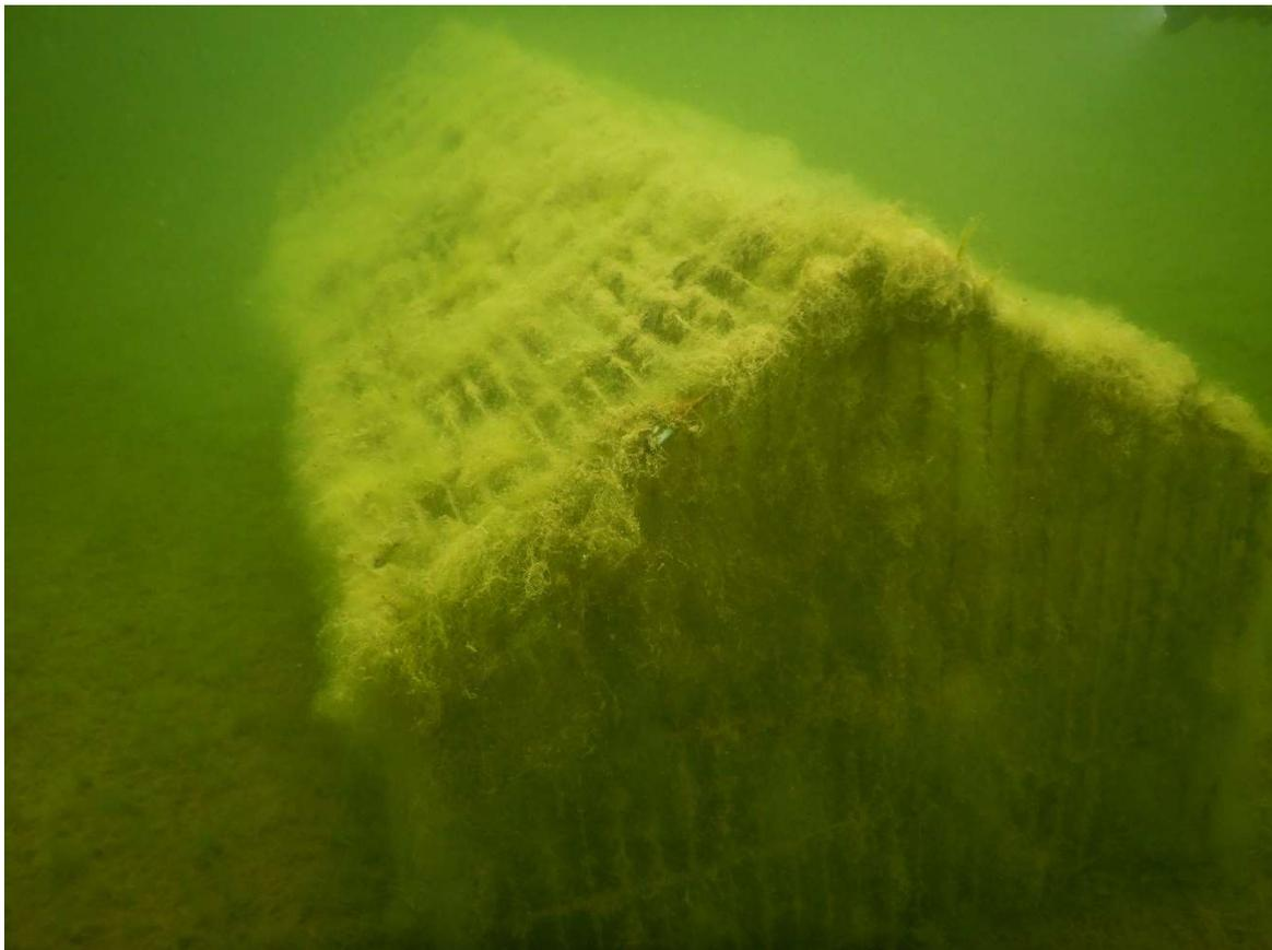
*Abb. 12 – Dichter Aufwuchs trotz kürzlicher Reinigung*
